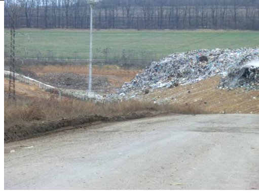
Рис. 6: Відходи на схилі котловану
